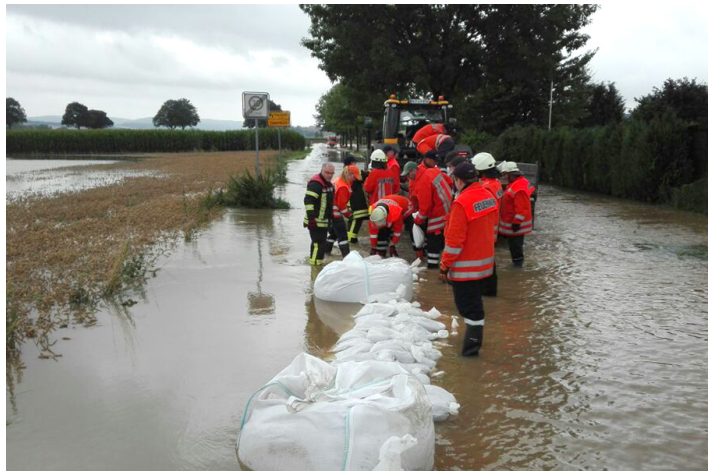
Die Einsatzkräfte der Regionsfeuerwehrbereitschaft IV bauten einen rund 500 Meter langen Dammen, um die Ortschaft Heersum zu vor dem Hochwasser zu schützen.
