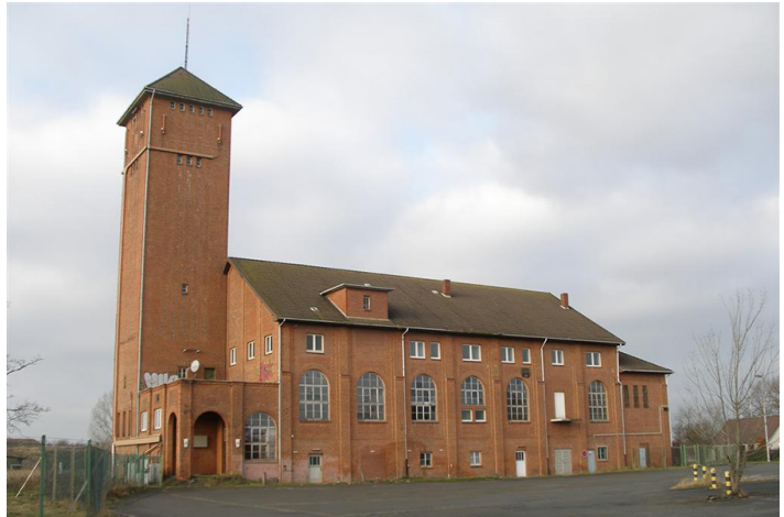
Der Wasserturm wird am kommenden Mittwoch gesprengt. / Foto: K+S
