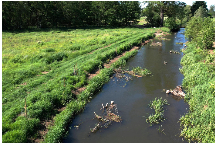
Aus der Vogelperspektive erkennt man den wechselseitigen Einbau der Strukturen. So kommt wieder Dynamik in den Fluss. / Foto: Frank Langer
