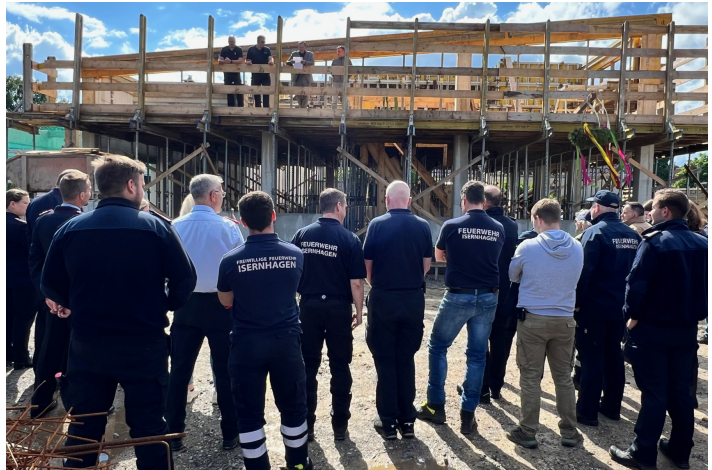
Gestern wurde auf der Baustelle des neuen Feuerwehrhauses in Isernhagen F.B. das Richtfest gefeiert. / Foto: Dana Noll
