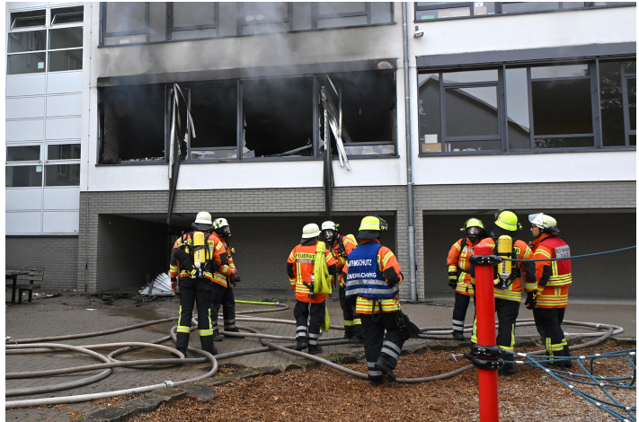
Am 8. Oktober 2023 brannte ein Klassenraum komplett aus, weitere Teile des Gebäudes wurden in Mitleidenschaft gezogen. / Foto: Bastian Kroll
